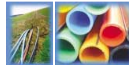
▲ Chráničky a jejich pokládka.
