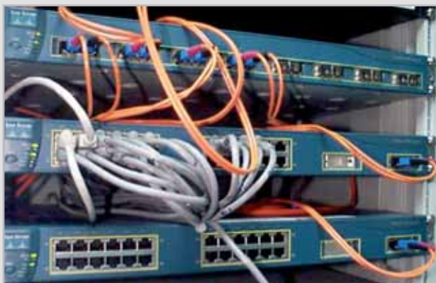
Lo standard 1000BaseT usa le stesse frequenze di lavoro di Fast Ethernet ed è quindi retrocompatibile con i cablaggi del vecchio standard
